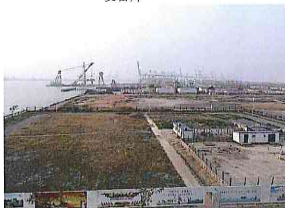
西侧道路（南向北拍摄）
