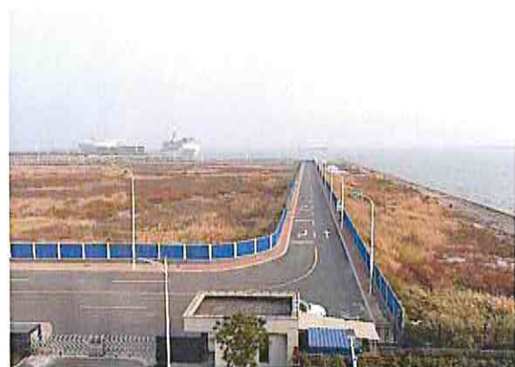
东侧道路（北向南拍摄）
